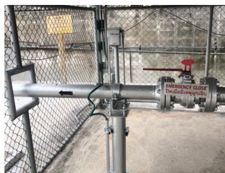
ภาพที่ 2.2-43 ระบบสายดิน
