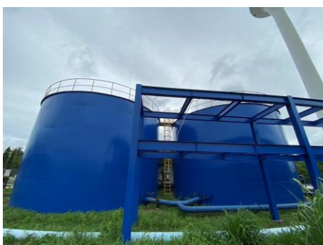
ภาพที่ 2.2-40 ถังสำรองน้ำใช้และน้ำดับเพลิง
