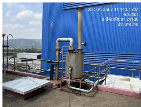
ภาพที่ 2.2-2 ระบบ Scrubber บริเวณปล่องหน่วยถลุงเตรียมสารเร่งปฏิกิริยา
