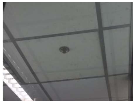
ระบบดับเพลิงอัตโนมัติ (Sprinkler)
